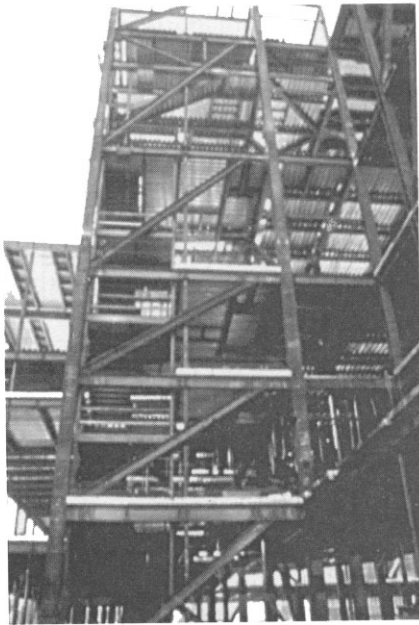
a. D-braced frames
